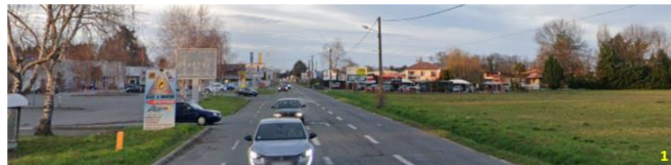
Vue sur la RD935 entre Borderes-sur-l'Echez et Aureilhan (Source : Nécodyme)
