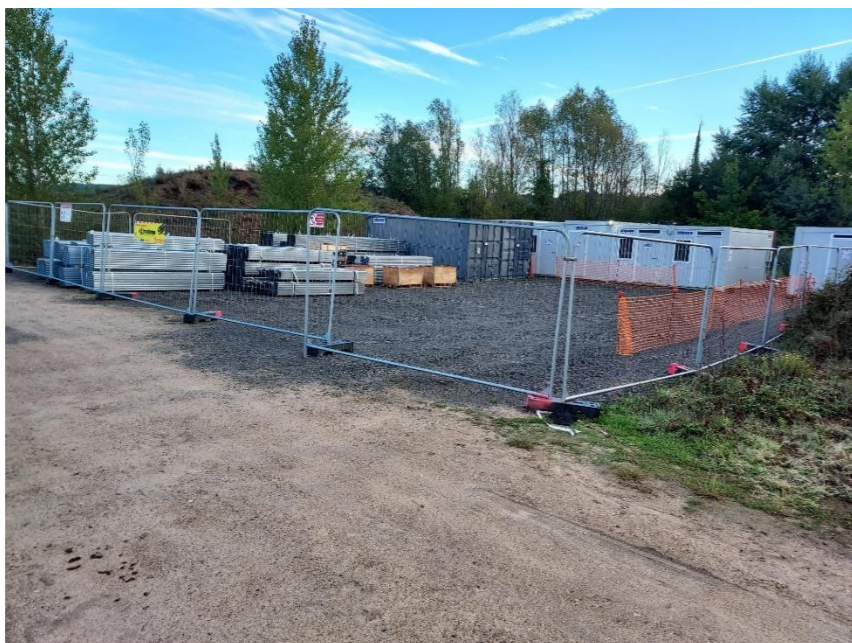
Exemple d'installation de base vie et de zone de stockage
