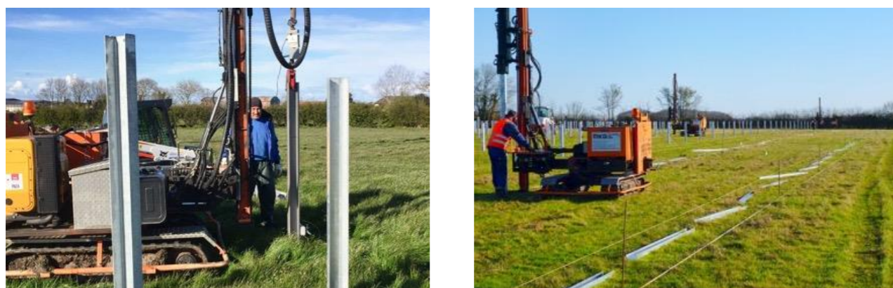
Exemple de batteuse de pieux (Source : mkg-goebel.de)
